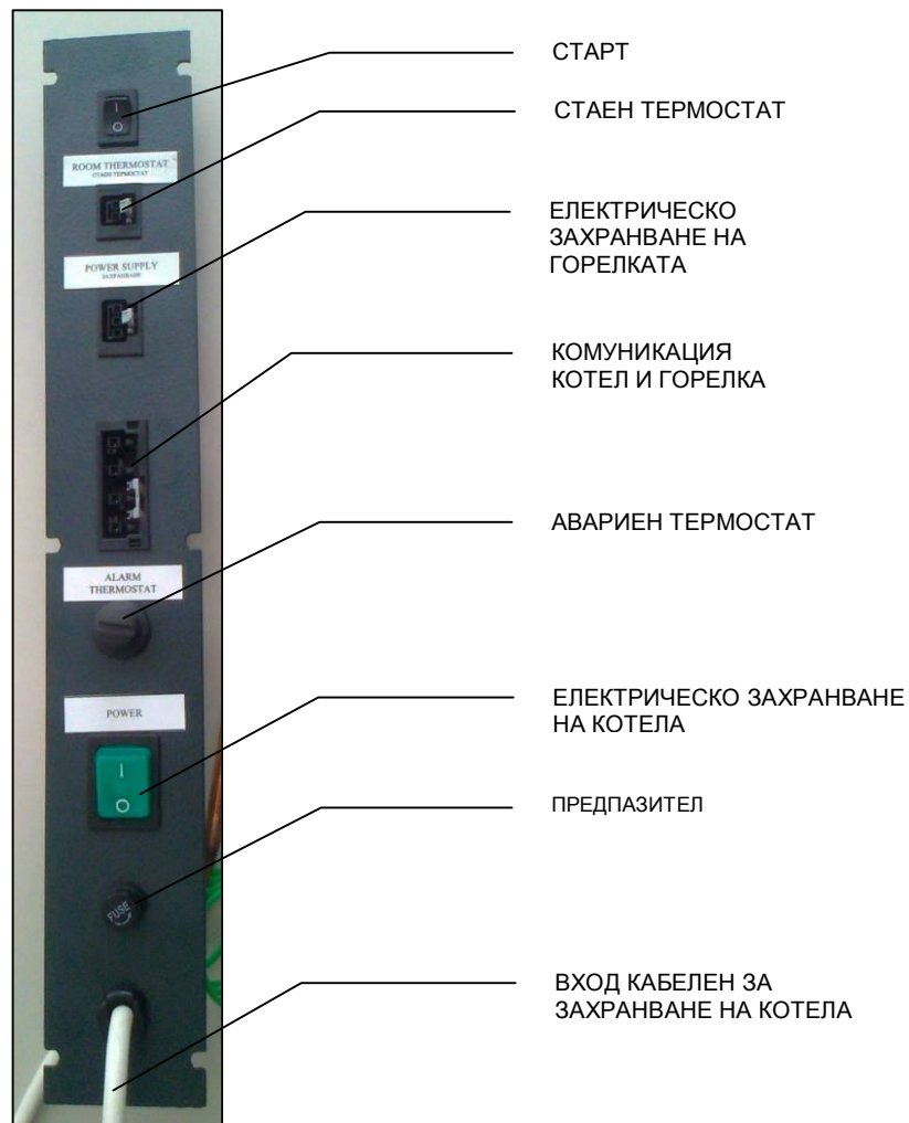
Фигура 10. Електрическо табло за управление на котела
